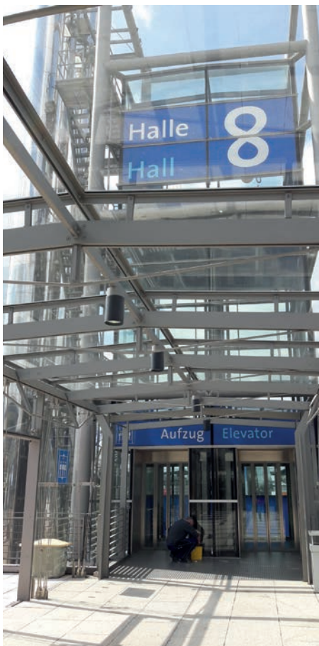
Bild 8: Reparatur am äußeren Taster des Aufzuges zur Halle 8
